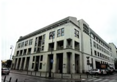
fot. 1 i 2. Widok ogólny budynku technicznego Teatru Narodowego w Warszawie – narożnik południowo-wschodni i północno-wschodni
