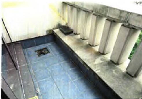
fot. 6. Widok ogólny małego tarasu przy zachodniej ścianie szczytowej budynku od strony ul. Fredry
