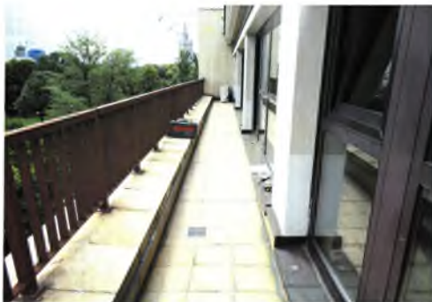
fot. 3. Widok ogólny tarasu III piętra budynku wzdłuż ul. Fredry
