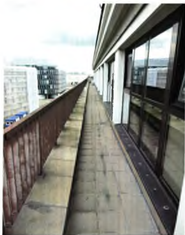
fot. 4 i 5. Widok ogólny tarasów III piętra budynku wzdłuż ul. Niecałej i ul. Wierzbowej
