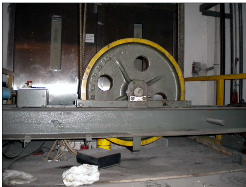
Zawieszenie kabiny
