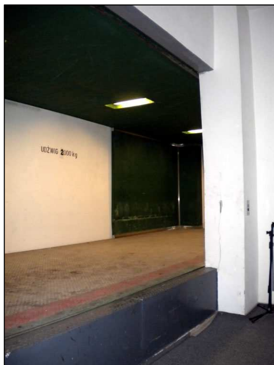
Zawężony otwór drzwiowy powyżej poziomu przystanku „5”
