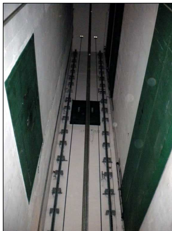
Wnętrze szybu powyżej przystanku „1”
