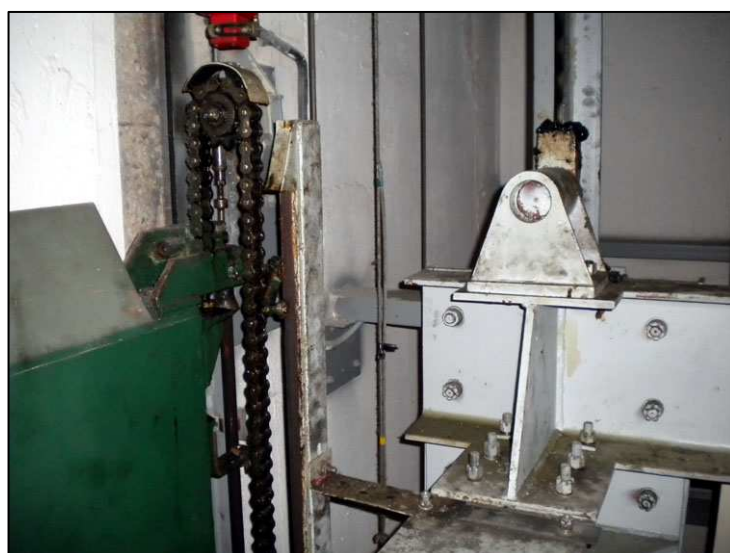
Prowadnik ramy kabinowej (zeliwny) i łańcuch napędu drzwi szybowych
