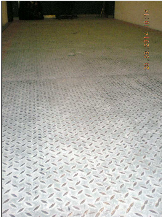
Zdeformowana podłoga w kabinie
