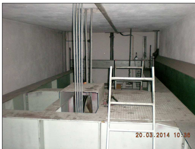
Zawieszenie ramy kabinowej
