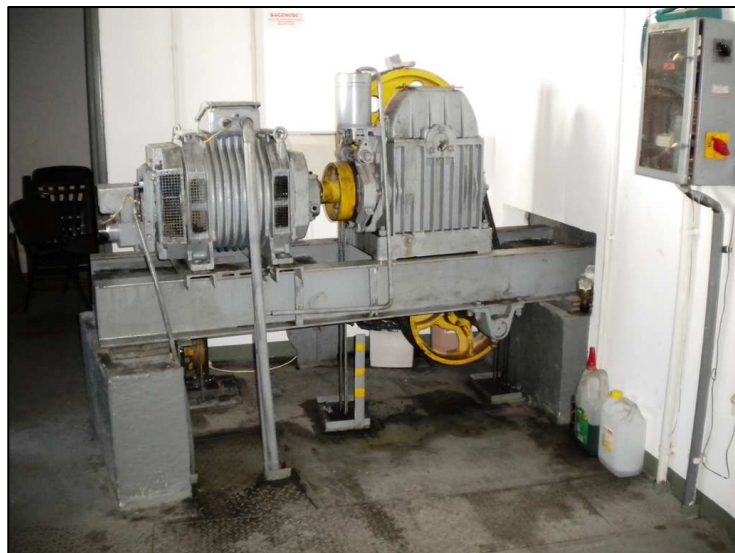
Tablica wstępna i zespół napędowy w maszynowni
