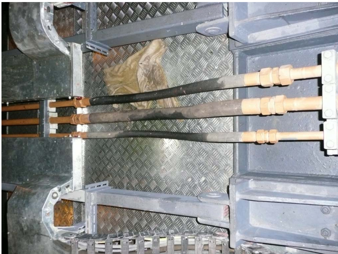
Fot. 26. Elastyczne przewody hydrauliczne dolnego przegubu podłogi wleczonej
