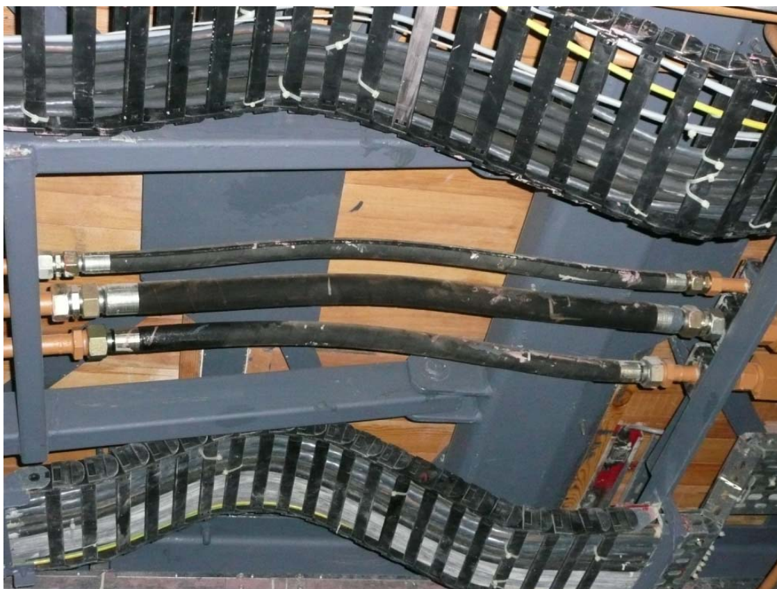
Fot. 24. Elastyczne przewody hydrauliczne górnego przegubu podłogi wleczonej
